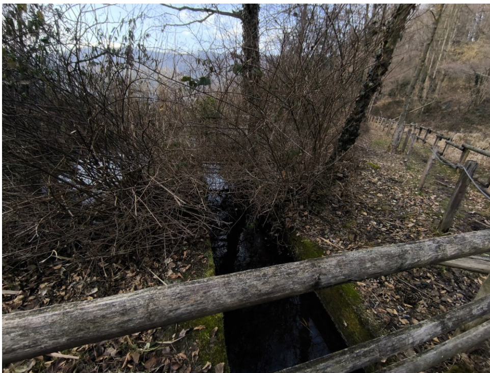
Fotografia 6 Punto di installazione stazione idrometrica
