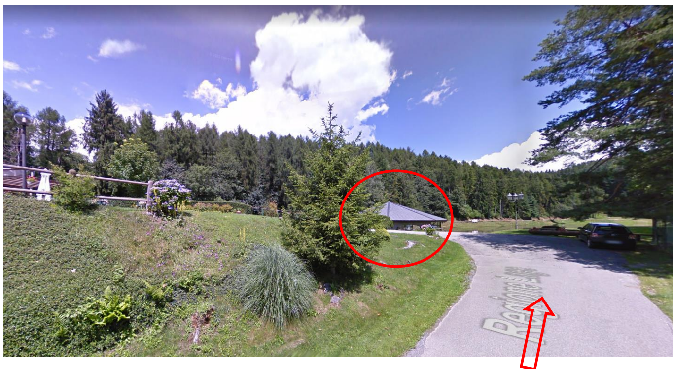
Strada di accesso all'area oggetto di intervento
