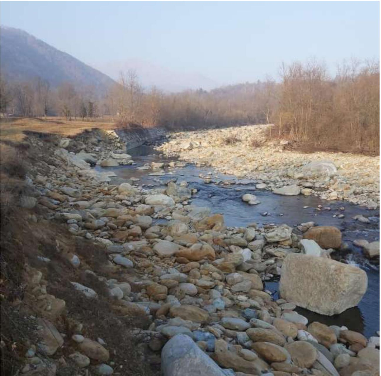
*Figura 11 – Foto scattata da valle verso monte, vista tratto di scogliera esistente in sponda dx e argine eroso dall'alluvione torrente Chiusella*
