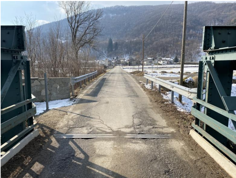
11. S.P. 64 - Vista dal ponte in direzione Trausella
