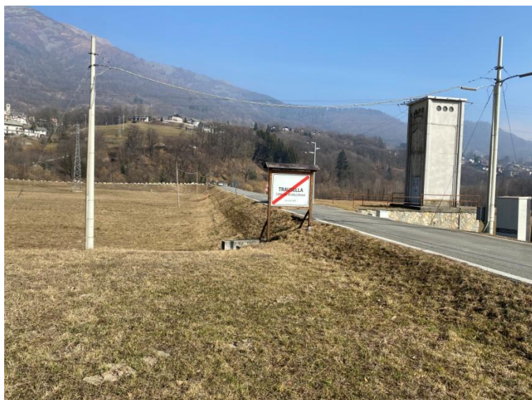
5. S.P. 64 - Fine centro abitato Trausella e cabina elettrica
