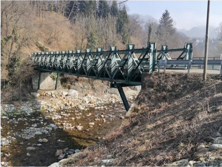
10. Ponte sul torrente Chiusella - Vista dal piazzale adiacente
