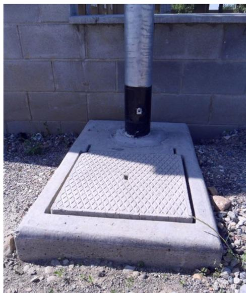
Figura 10 – Plinto prefabbricato per palo IP con pozzetto integrato
