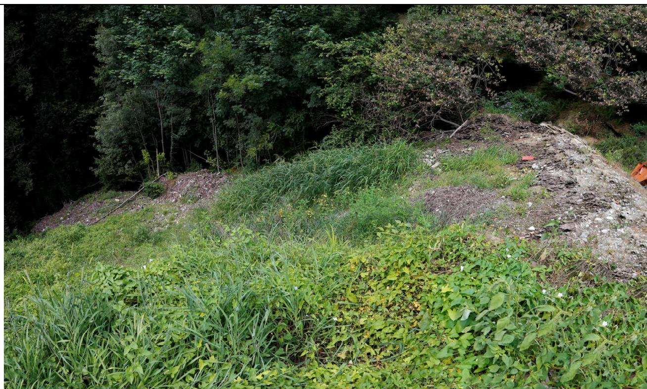
Foto n.2 – Veduta complessiva dell'area dissestata. Risultano evidenti i caratteri del coronamento e della zona di accumulo, risultando celata dalla vegetazione la porzione mediana dell'alveo di frana.
