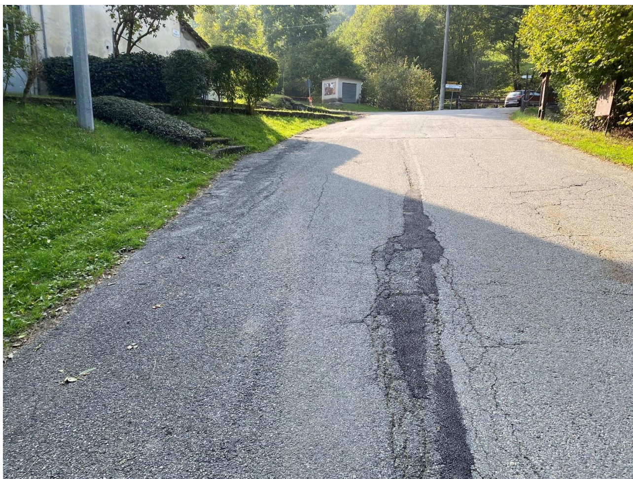
Figura 7 – Intervento 3, vista del tratto di strada oggetto di intervento
