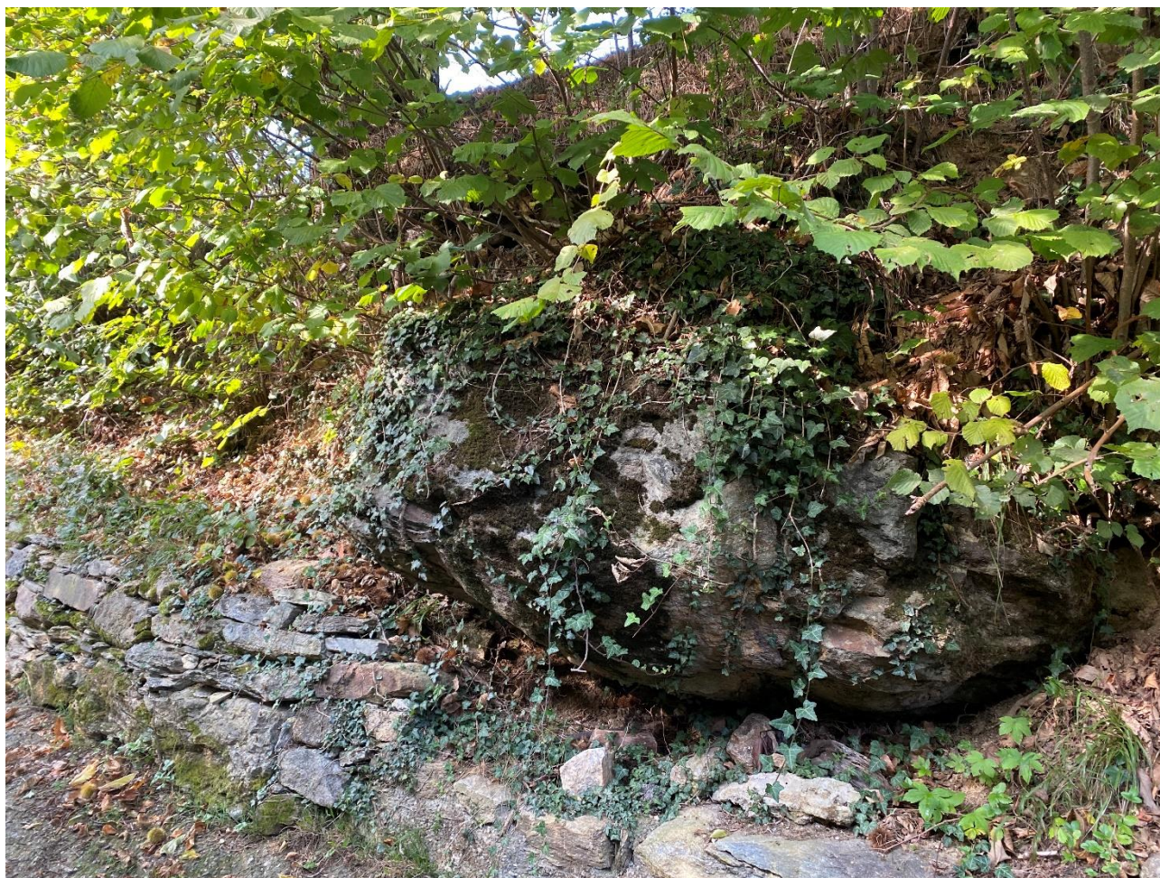
Figura 2 – Intervento 1, vista del masso da demolire parzialmente
