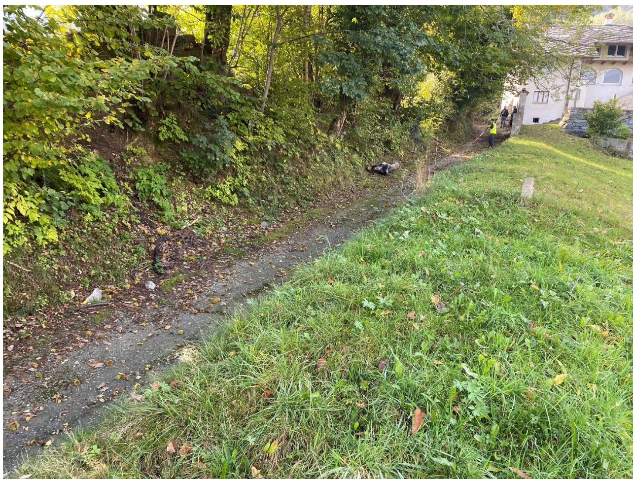
Figura 4 –Intervento 1, vista in parte della strada oggetto di intervento e del tratto dove verranno posati i cordoli in cls
