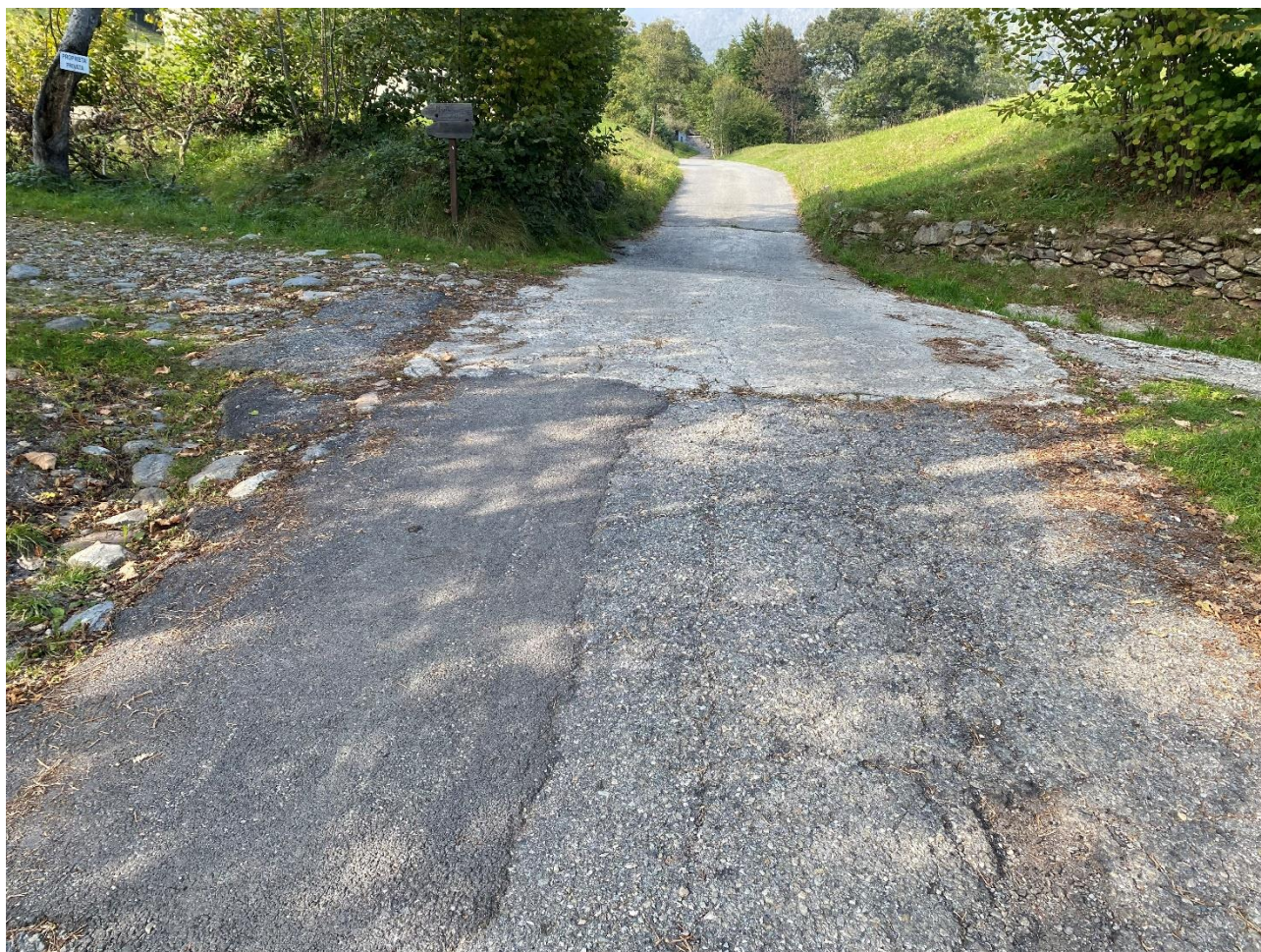
Figura 1 – Intervento 1, vista in parte del tratto di strada dove si andrà a scarificare per uno spessore di 4 cm e verrà steso uno strato di binder per uno spessore di 6 cm.
