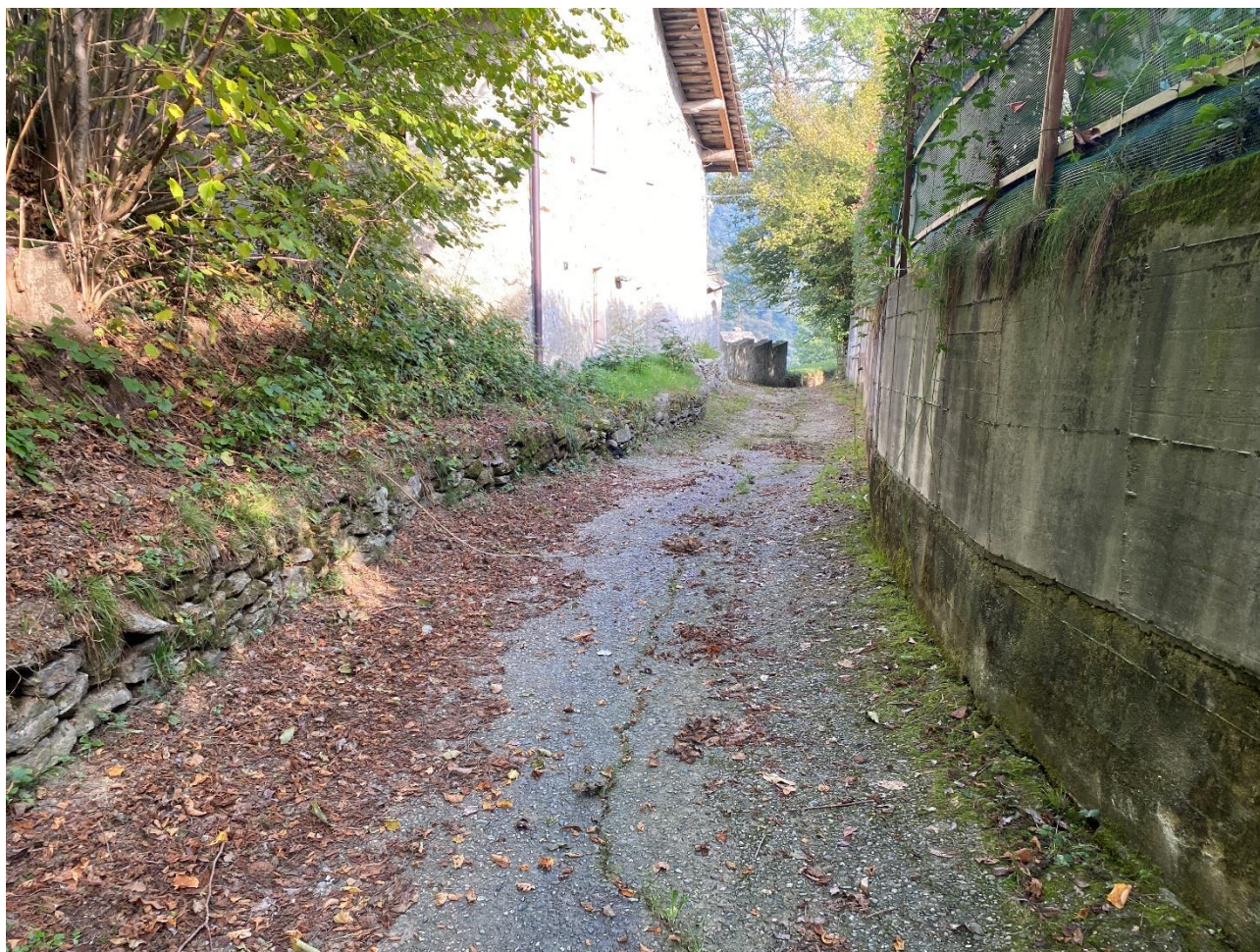
Figura 3 – Intervento 1, vista del muro in pietrame a secco da arretrare al fine di allargare la strada, vista in parte della strada oggetto di intervento
