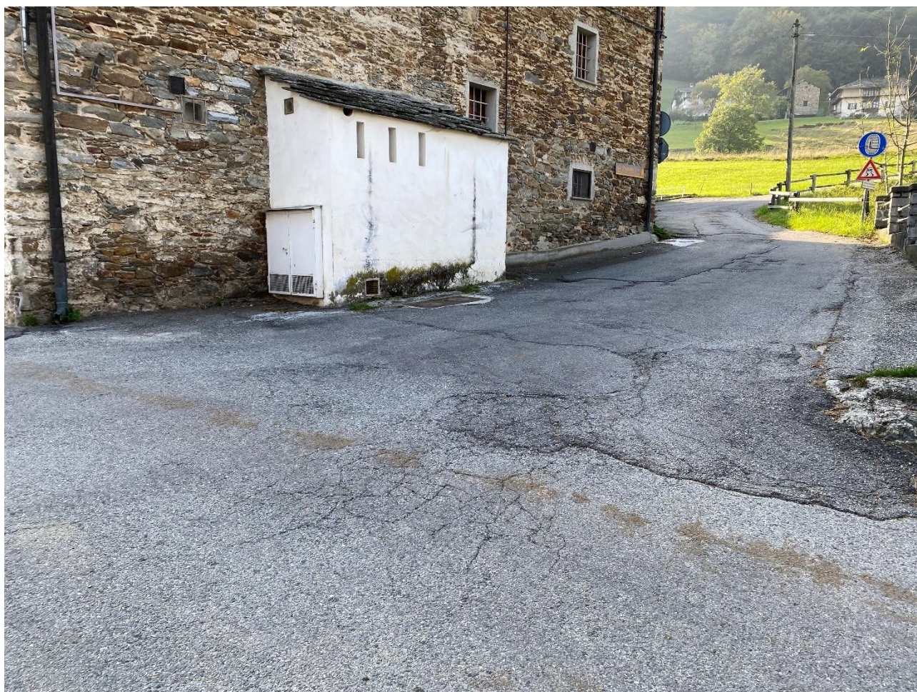
Figura 5 – Intervento 2, vista in parte della strada oggetto di intervento
