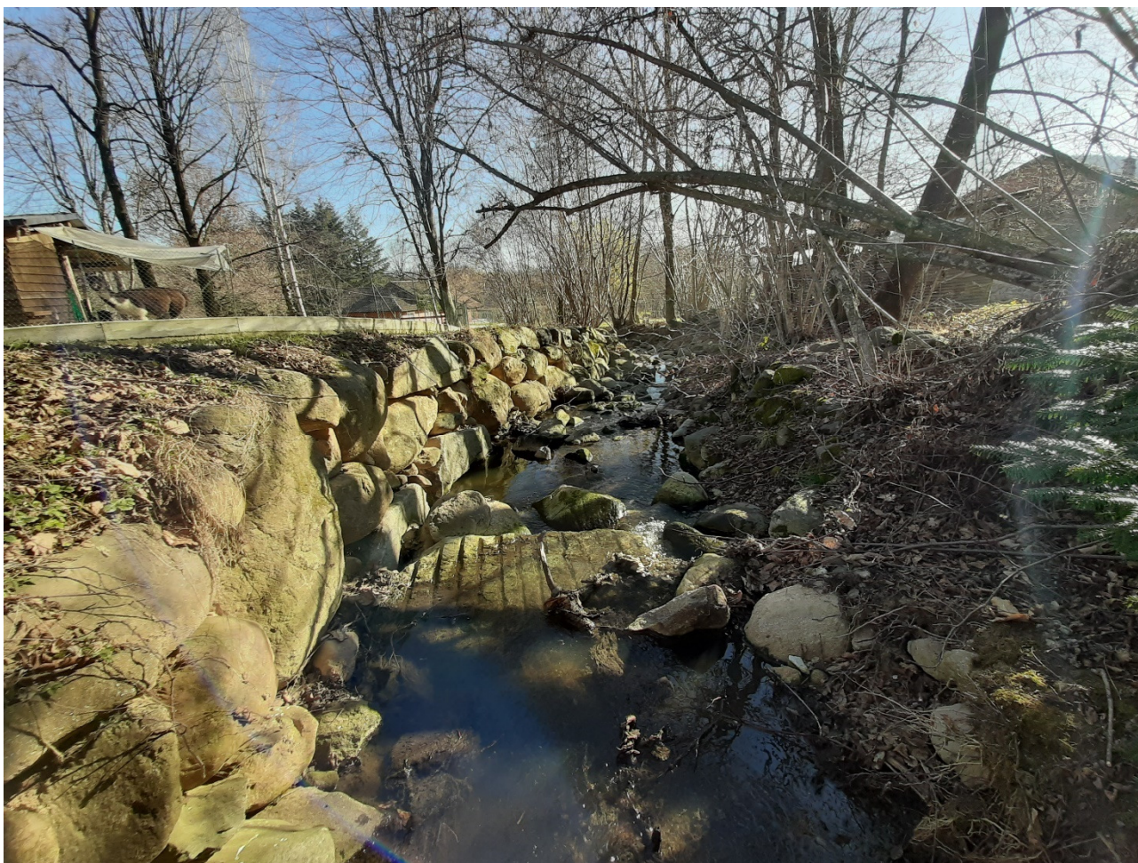
Foto 2: Scogliera esistente da demolire
