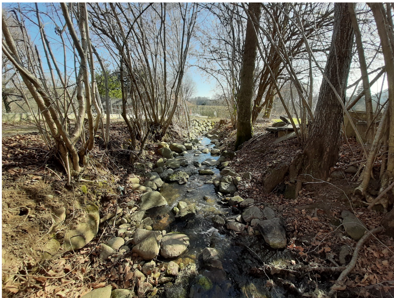
Foto 4: Sponda in sinistra idrografica in erosione
