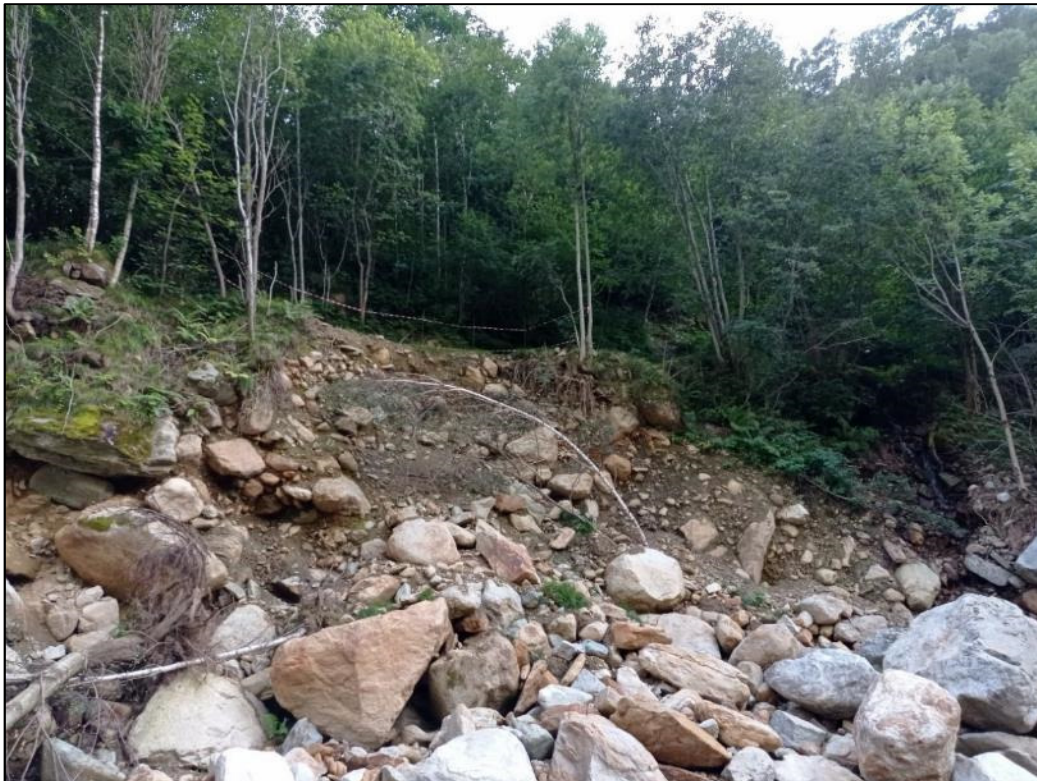
Nota esplicativa: Foto 1. Vista della frana dall'alveo del torrente Chiusella.
