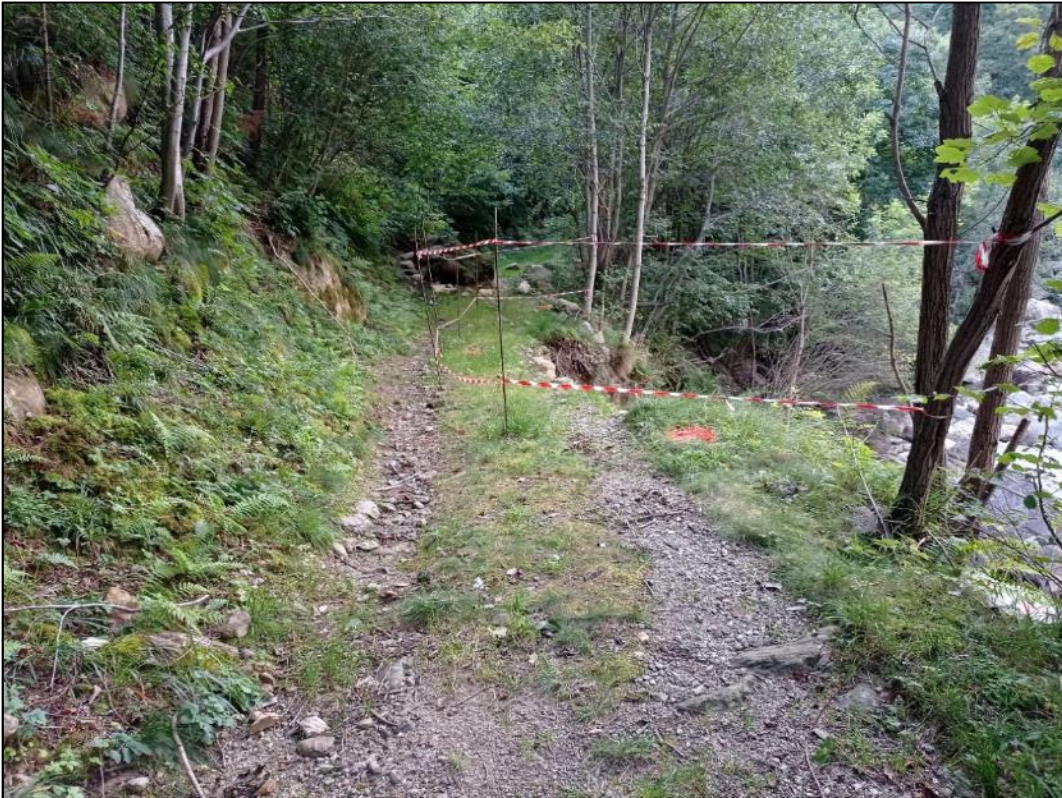
Nota esplicativa: Foto 5. Tratto del versante franato, vista da est lungo la pista esistente.
