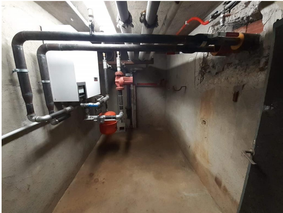
Sottostazione teleriscaldamento: lavori di inserimento gruppi pompaggio, bollitore ACS
