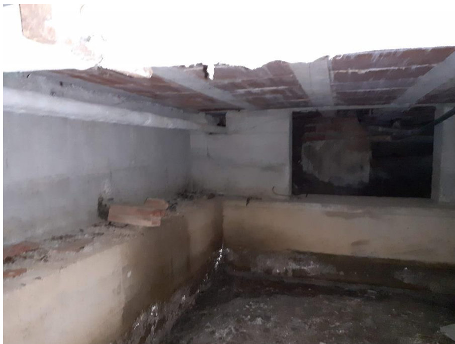
Interrato: lavori di coibentazione tubazioni
