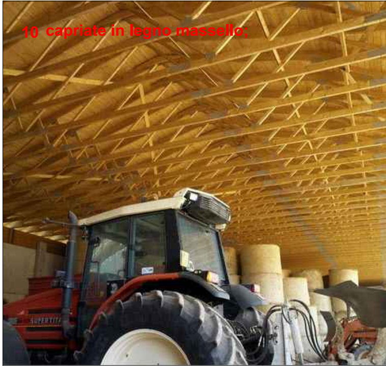
PREVALENTE USO DEL LEGNAME COME STRUTTURA PORTANTE DELL'EDIFICIO
