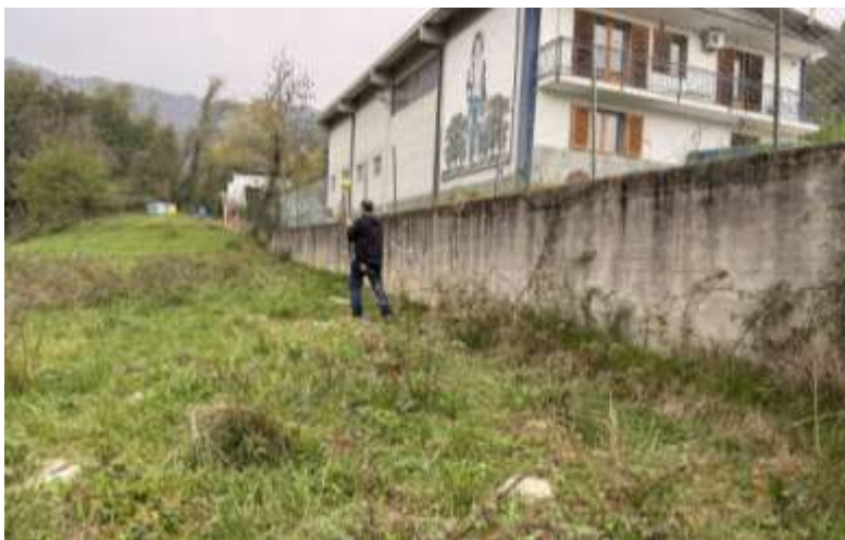
Scatto Fotografico 2 - Parte elevata del lotto, a confine con recinzione esistente
