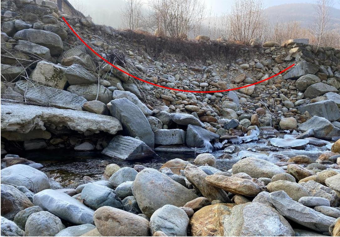
*Figura 14: Torrente Chiusella, erosione sponda destra con cedimento spondale già avvenuto in prossimità di edificio*
