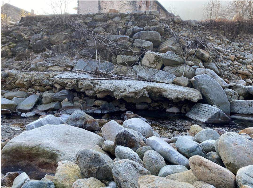
*Figura 15: Torrente Chiusella, dettaglio del cedimento spondale e dell'erosione in atto al piè di sponda sotto edificio*
