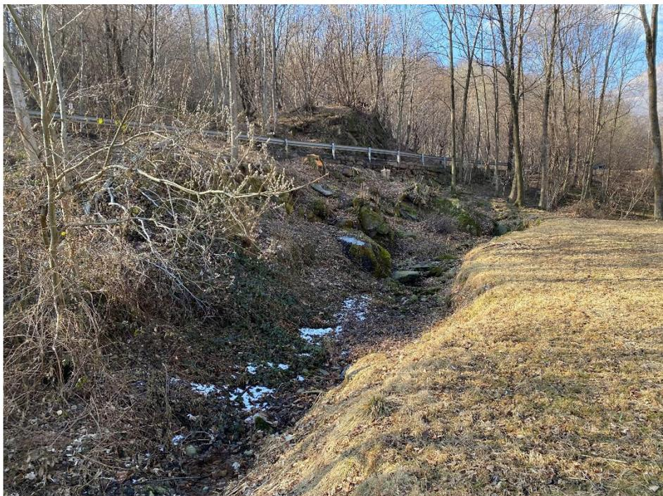
*Figura 10: Frazione Inverso, deviazione del rio verso Torrente Chiusella con in evidenza l'irregolarità ed il forte inerbimento dell'alveo*
