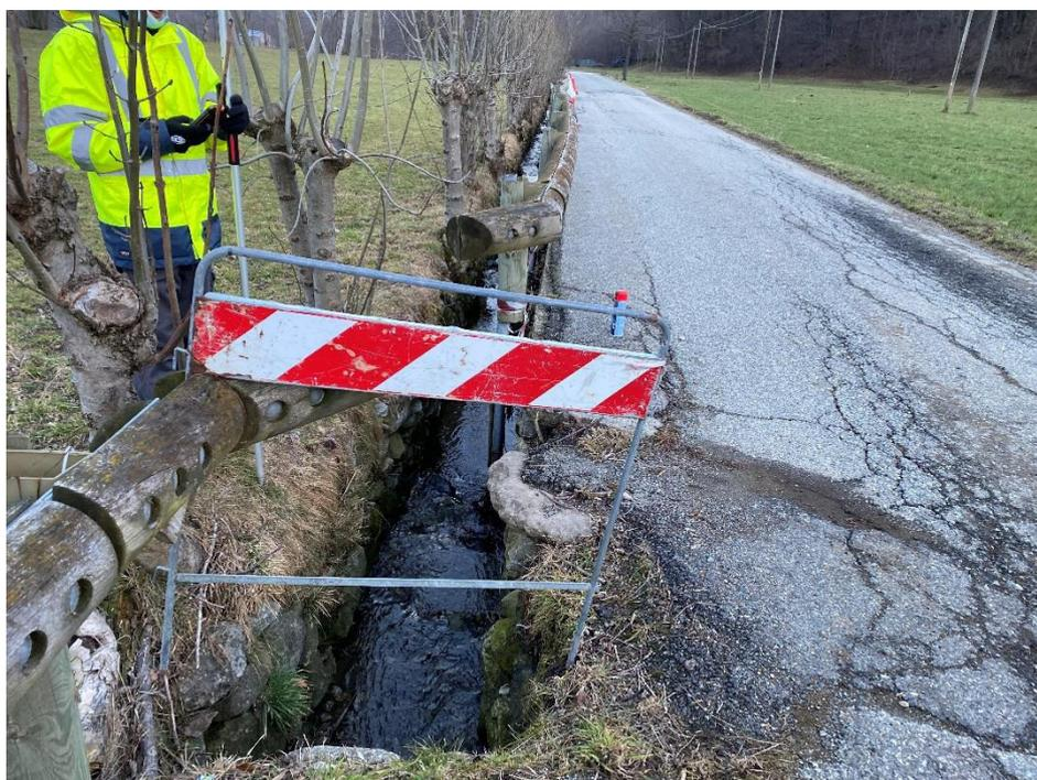
*Figura 8: Frazione Inverso, restringimento carreggiata Strada Maestra causa presenza canale bordo strada*
