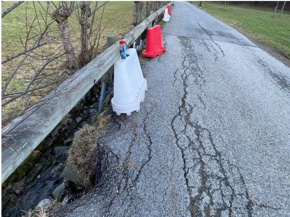
*Figura 9: Frazione Inverso, esempio di cedimento della pavimentazione stradale a causa dei fenomeni di erosione*
