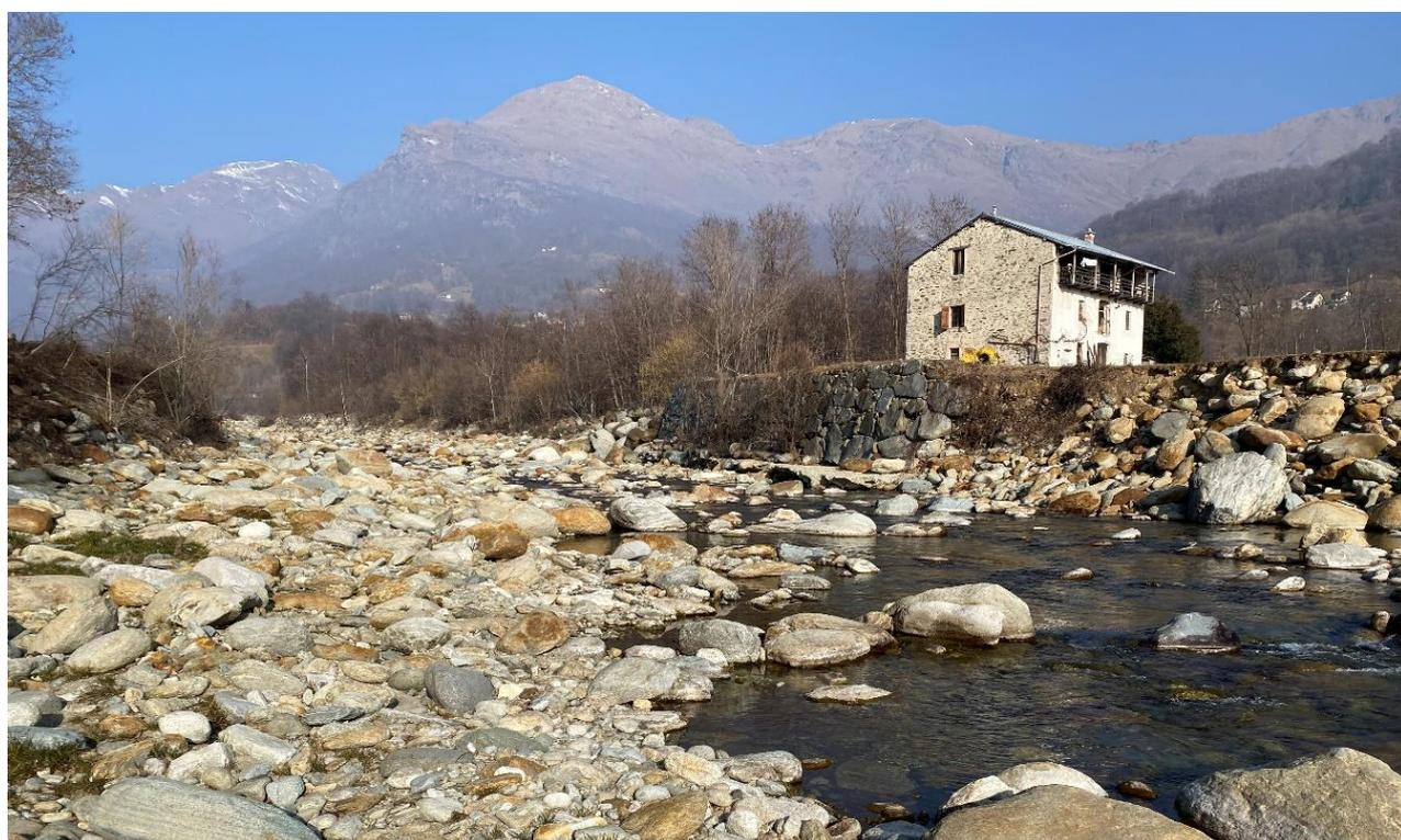
*Figura 10: Torrente Chiusella, vista in direzione nord, in evidenza scogliera in sinistra idraulica*
