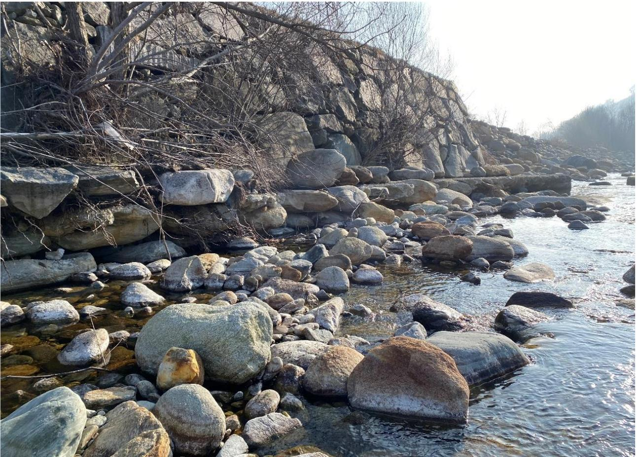
*Figura 6: Torrente Chiusella, erosione a piè di sponda in sinistra idraulica*
