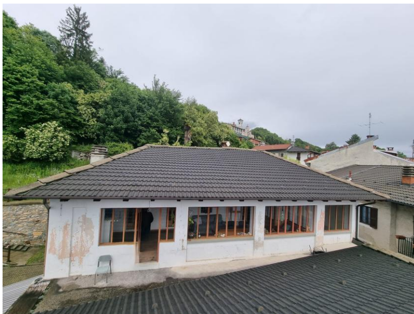
Edificio e falda oggetto di intervento
