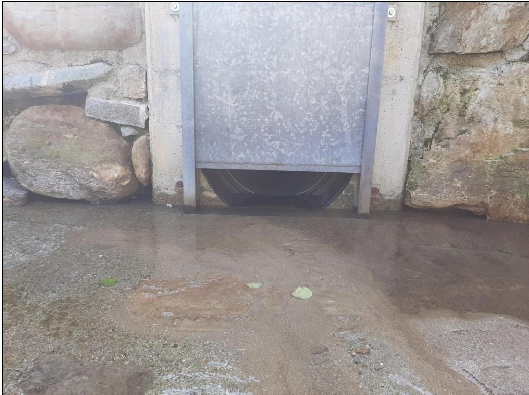
*Figura 4: Paratoia a monte della canalizzazione esistente costituita da una tubazione interrata.*
